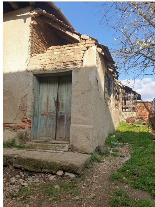
FOTO 19, FOTO 20 –Fațada laterală dreapta. Lipsește complet burlanul de la jonțiunea dintre corpul principal și corpul mic, amplasat în lateral incomplet la colț, astfel că apa pluvială captată de pe acoperiș se scurge din jgheaburi direct pe peretele exterior. La corpul mic lipsește sistemul de jgheaburi și burlane. Din cauza apei care s-a scurs direct pe pereți, s-au produs degradări ale zidăriei la corpul lateral
