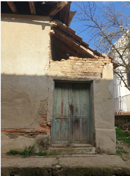
FOTO 19, FOTO 20 –Fațada laterală dreapta. Lipsește complet burlanul de la jonțiunea dintre corpul principal și corpul mic, amplasat în lateral incomplet la colț, astfel că apa pluvială captată de pe acoperiș se scurge din jgheaburi direct pe peretele exterior. La corpul mic lipsește sistemul de jgheaburi și burlane. Din cauza apei care s-a scurs direct pe pereți, s-au produs degradări ale zidăriei la corpul lateral
