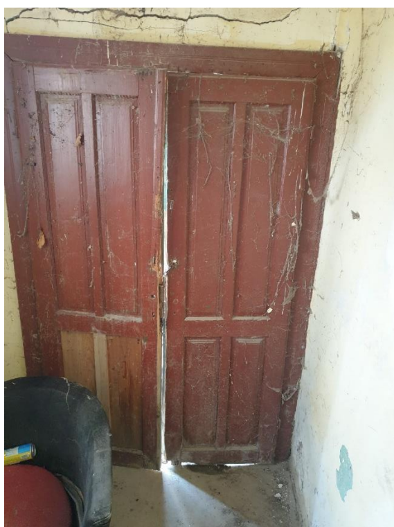
FOTO 49, FOTO 50 –Imagini din interiorul corpului lateral. Tencuieli afectate de umiditate, pe punctul de a cădea, ușa acces secundar veche, defectă
