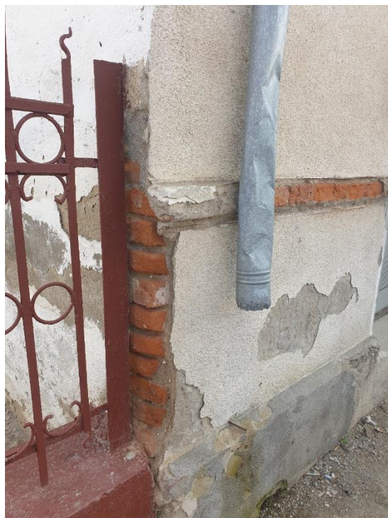
FOTO 8, FOTO 9 – Fațada principală., burlan incomplet la colț, prin care nu se mai asigură îndepărtarea apelor pluviale de la construcție, acestea scurgându-se chiar în dreptul fundației
