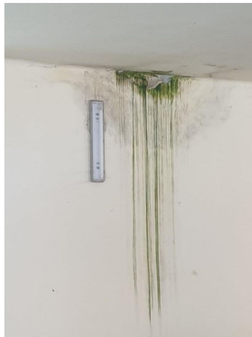
FOTO 29, FOTO 30 – Vederi din interior. Apă scursă din pod în centrul tavanului sălii și pe perete lateral. Întrucât este prezentă și microvegetație la nivelul zonelor umede, situația durează de mai mult timp
