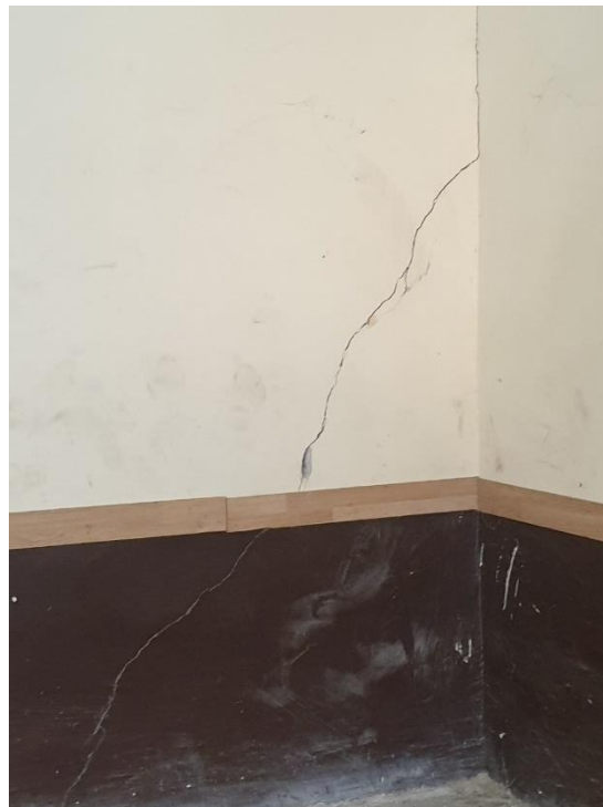
FOTO 39, FOTO 40 –Fisură la 45° la perete interior care delimitează sala de scenă
