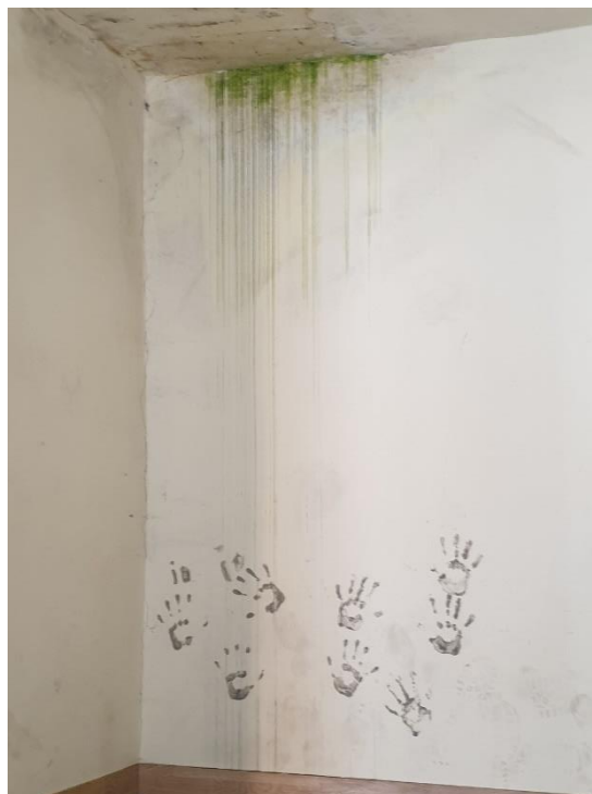
FOTO 41, FOTO 42 –Scurgeri de apă din pod pe peretele exterior. Zugrăveli vechi și murdare
