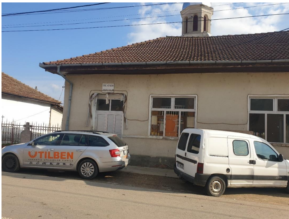
FOTO 4 – Vedere din exterior – fațadă principală
