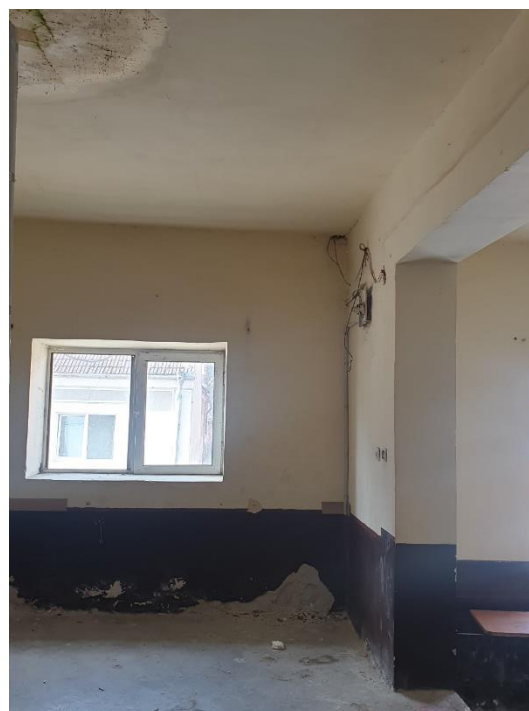
FOTO 34, FOTO 35 –Imagini din interior. Zugrăveli și vopsitorii învechite, exfoliate. Pardoseală din ciment sclivisit. Scurgeri de apă din pod la tavan
