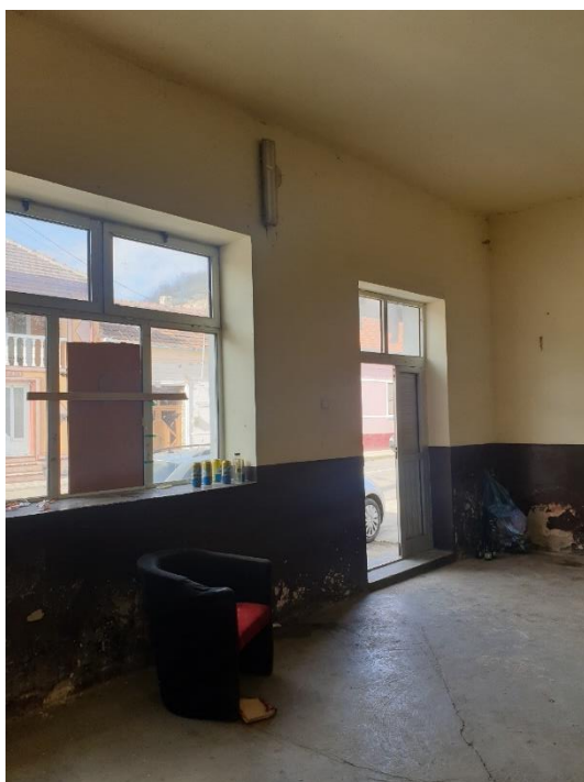
FOTO 34, FOTO 35 –Imagini din interior. Zugrăveli și vopsitorii învechite, exfoliate. Pardoseală din ciment sclivisit. Scurgeri de apă din pod la tavan
