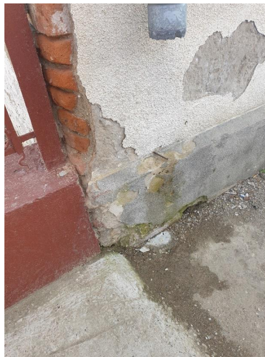
FOTO 8, FOTO 9 – Fațada principală., burlan incomplet la colț, prin care nu se mai asigură îndepărtarea apelor pluviale de la construcție, acestea scurgându-se chiar în dreptul fundației
