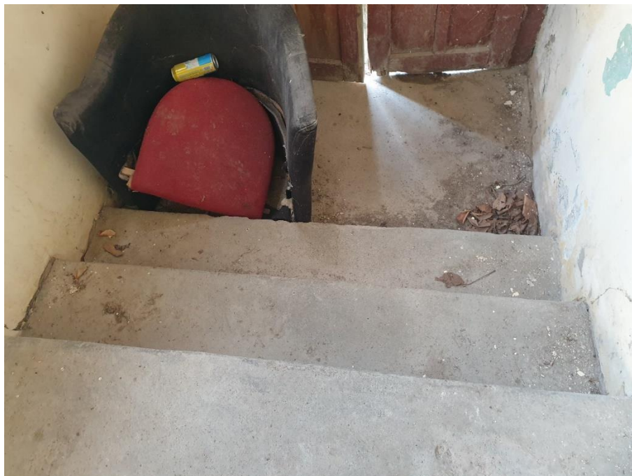
FOTO 48 –Imagini din interiorul corpului lateral. Trepte beton existente
