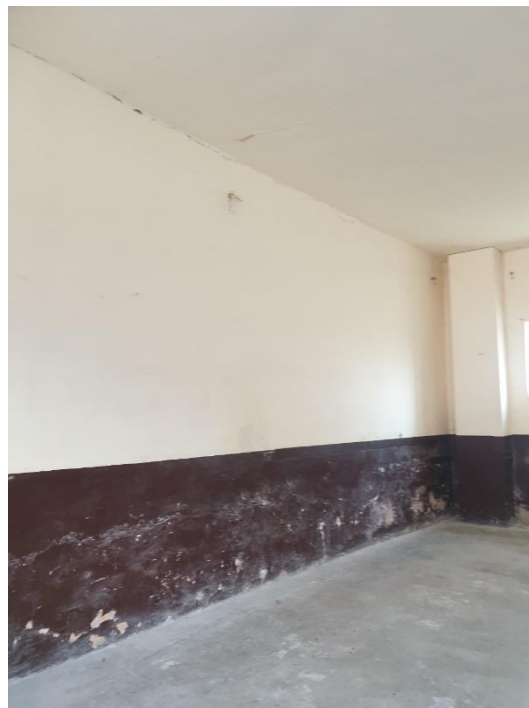
FOTO 26, FOTO 27 – Vederi din interior. Coș de fum existent la colț. Pardoseală ciment sclivisit. Zugrăveli și vopsitorii învechite, exfoliate
