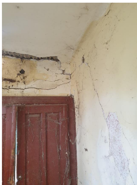
FOTO 49, FOTO 50 –Imagini din interiorul corpului lateral. Tencuieli afectate de umiditate, pe punctul de a cădea, ușa acces secundar veche, defectă
