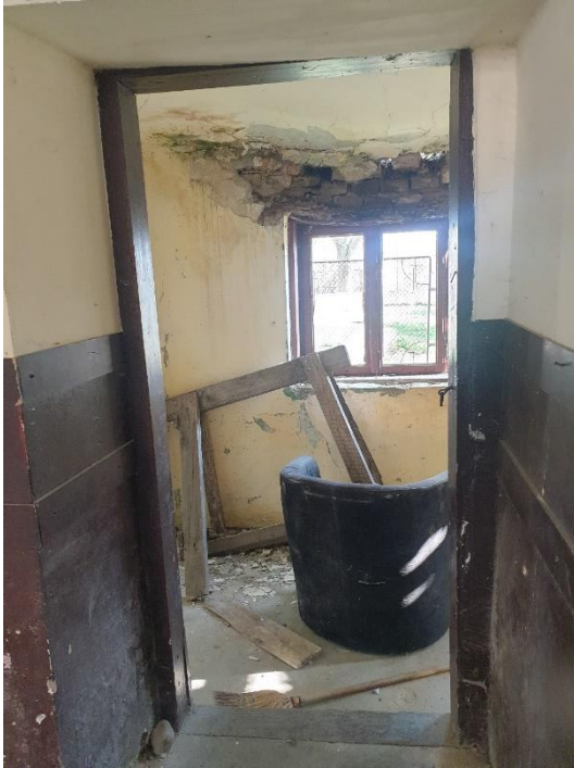
FOTO 43, FOTO 44 –Imagini din interiorul corpului lateral. Deoarece lipsește sistemul de jgheaburi și burlane la acest corp lateral și lipsesc și țigle, cornișa este ruptă și căzută parțial, apa s-a scurs și în interior, pe pereți, producând în timp degradări ale zidăriei, putrezirea buiandrugului din lemn care este în pragul colapsului, prăbușirea unor porțiuni din ziduri și o degradare a cărămizilor și liantului din rosturi
