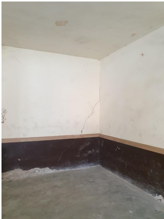
FOTO 39, FOTO 40 –Fisură la 45° la perete interior care delimitează sala de scenă
