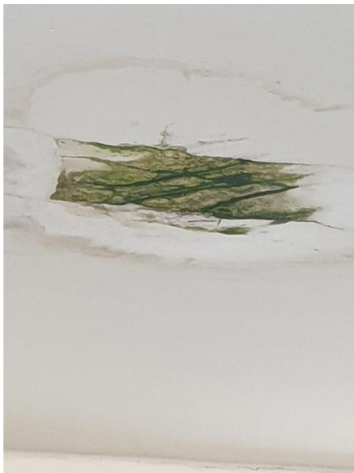
FOTO 29, FOTO 30 – Vederi din interior. Apă scursă din pod în centrul tavanului sălii și pe perete lateral. Întrucât este prezentă și microvegetație la nivelul zonelor umede, situația durează de mai mult timp
