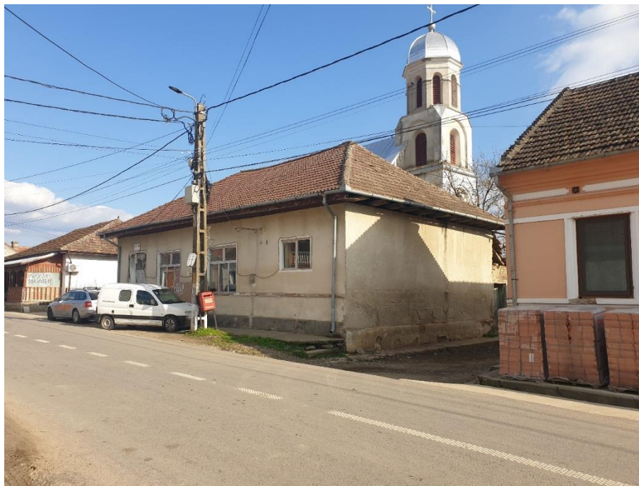
FOTO 1 – Vedere din exterior – amplasare, vecinătăți
