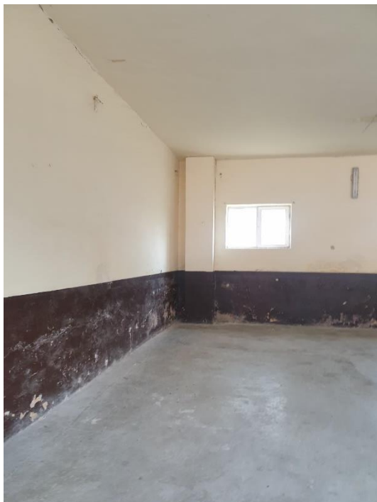
FOTO 26, FOTO 27 – Vederi din interior. Coș de fum existent la colț. Pardoseală ciment sclivisit. Zugrăveli și vopsitorii învechite, exfoliate
