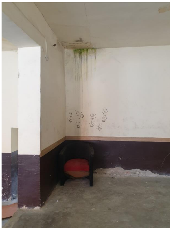
FOTO 41, FOTO 42 –Scurgeri de apă din pod pe peretele exterior. Zugrăveli vechi și murdare
