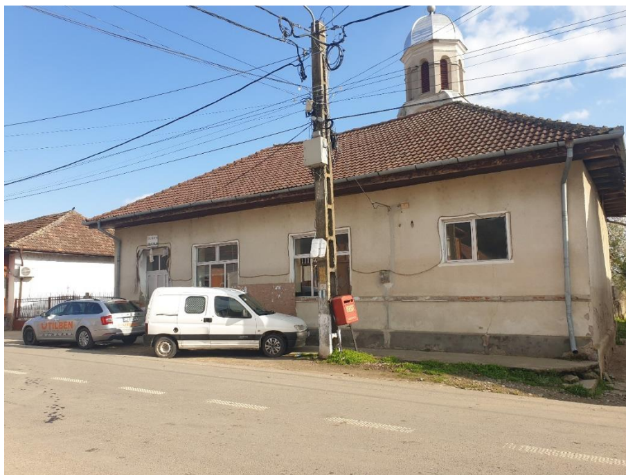
FOTO 2 – Vedere din exterior – fațadă principală
