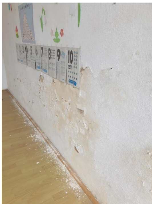
FOTO 58, FOTO 59 –Imagini din interior, încăperile dinspre stradă (camerele 3, 4). Zugrăvelile sunt vechi și cu zone exfoliate. La baza pereților, tencuiala prezintă desprinderi locale, indicând prezența umidității la partea inferioară a pereților
