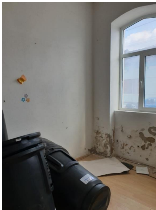
FOTO 49, FOTO 50 –Imagini din interior, încăperile dinspre stradă (camerele 3, 4). Zugrăvelile sunt vechi și cu zone exfoliate. La baza pereților, tencuiala este măcinată, cu desprinderi locale, indicând prezența umidității la partea inferioară a pereților, Tâmplăriile sunt vechi și degradate.
