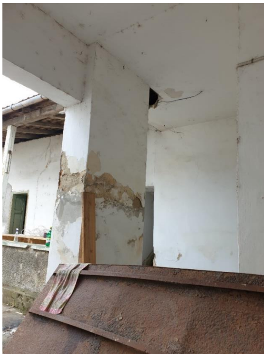
FOTO 10, FOTO 11 –Șpalet zidărie pe care reazemă grinda din vecinătatea șirului 3, dintre B și C (pe latura dinspre curte a intrării uscate). Local, tencuiala șpaletului este măcinată, parțial desprinsă
