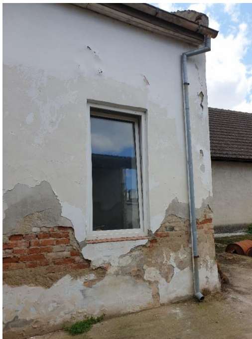
FOTO 18, FOTO 19 – Perete portant longitudinal ax B și perete transversal șir 4 – zona de intersecție B4. Tencuiala este măcinată, parțial desprinsă la partea inferioară a peretelui, umiditate prezentă la partea inferioară a pereților. Calcan existent spre curte, la zidul transversal. Alipire la construcția de pe parcela învecinată din partea stângă
