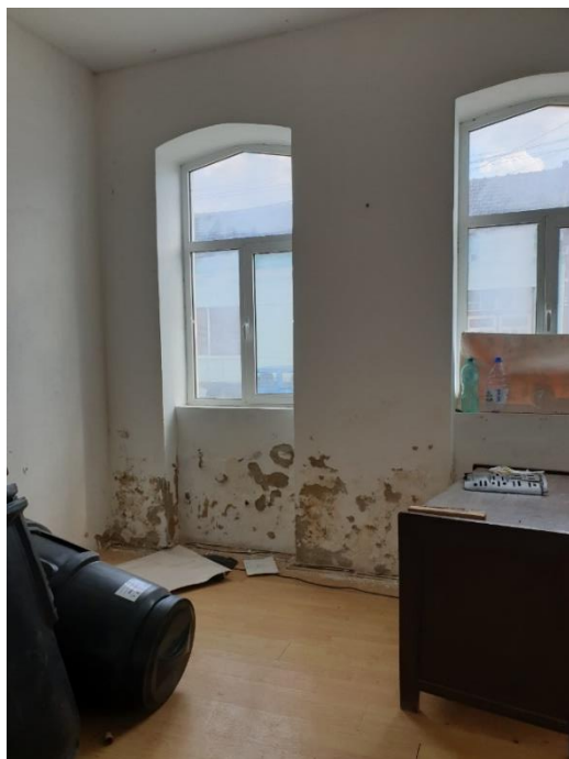
FOTO 49, FOTO 50 –Imagini din interior, încăperile dinspre stradă (camerele 3, 4). Zugrăvelile sunt vechi și cu zone exfoliate. La baza pereților, tencuiala este măcinată, cu desprinderi locale, indicând prezența umidității la partea inferioară a pereților, Tâmplăriile sunt vechi și degradate.
