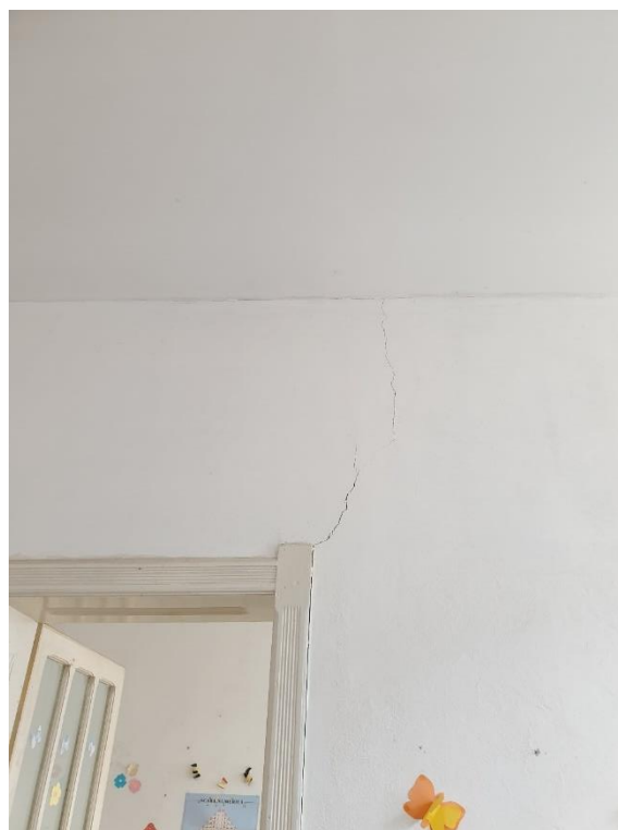
FOTO 53 –Fisură la \sim 45^\circ plecând din colul golului prezentă la perete portant
