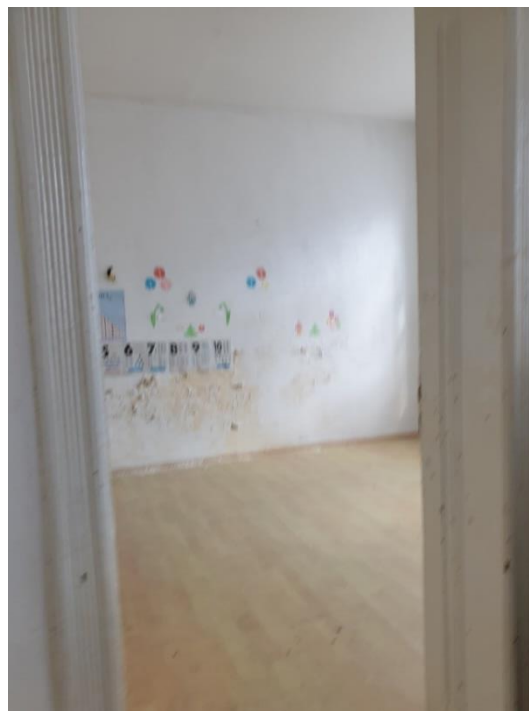
FOTO 51, FOTO 52 –Imagini din interior, încăperile dinspre stradă (camerele 3, 4). Zugrăvelile sunt vechi și cu zone exfoliate. La baza pereților, tencuiala este măcinată, cu desprinderi locale, indicând prezența umidității la partea inferioară a pereților, Tâmplăriile sunt vechi și degradate.
