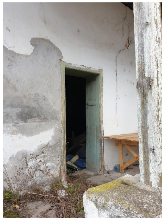
FOTO 28, FOTO 29 – Pridvor cu stâlpii deformați, elementele din lemn ale acoperișului afectate de umiditate și deformat, jgheaburi vechi și deformat. Fisuri/crăpături prezente la perete longitudinal ax D, între 4 și 5. Vegetație crescută pe pardoseala din beton a pridvorului. Tencuieli reparate impropriu. Tâmplării vechi, degradate
