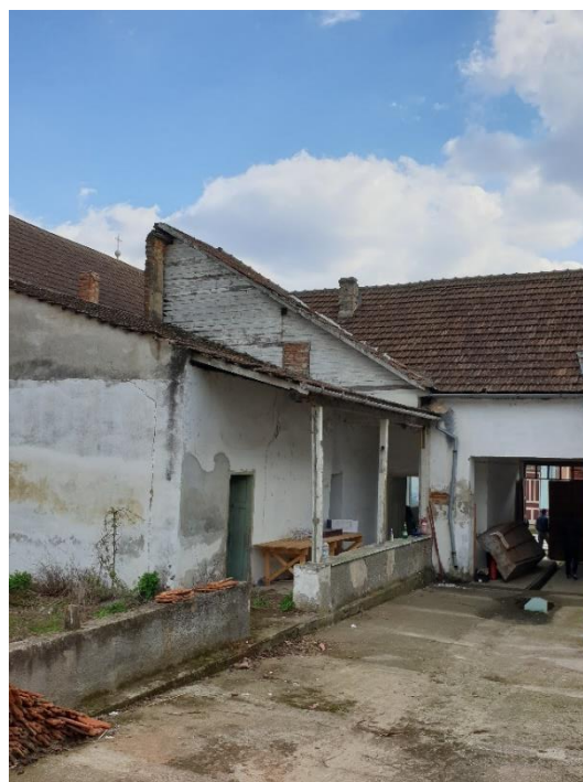
FOTO 23, FOTO 24 — Fisuri prezente la pereții portanți de pe șir 5, dintre D și F și din ax D, dintre 3 și 5. Pridvor cu stâlpii din lemn deformați, parapet afectat de umiditate, cu tencuiala desprinsă. Calcan existent pe șir 3, între D și F, închis cu scânduri, puternic afectate de umiditate. Țigla este învechită la toate apele dinspre curte, a fost înlocuită doar spre stradă.
