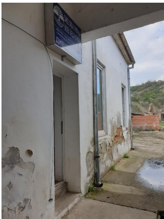
FOTO 14, FOTO 15 –Perete portant longitudinal ax B, zona dintre șirurile 2 și 4. Local, tencuiala este măcinată, parțial desprinsă la partea inferioară a peretelui. Burlan vechi, neetanș
