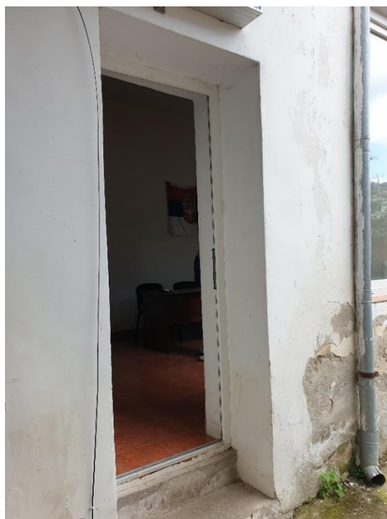
FOTO 14, FOTO 15 –Perete portant longitudinal ax B, zona dintre șirurile 2 și 4. Local, tencuiala este măcinată, parțial desprinsă la partea inferioară a peretelui. Burlan vechi, neetanș
