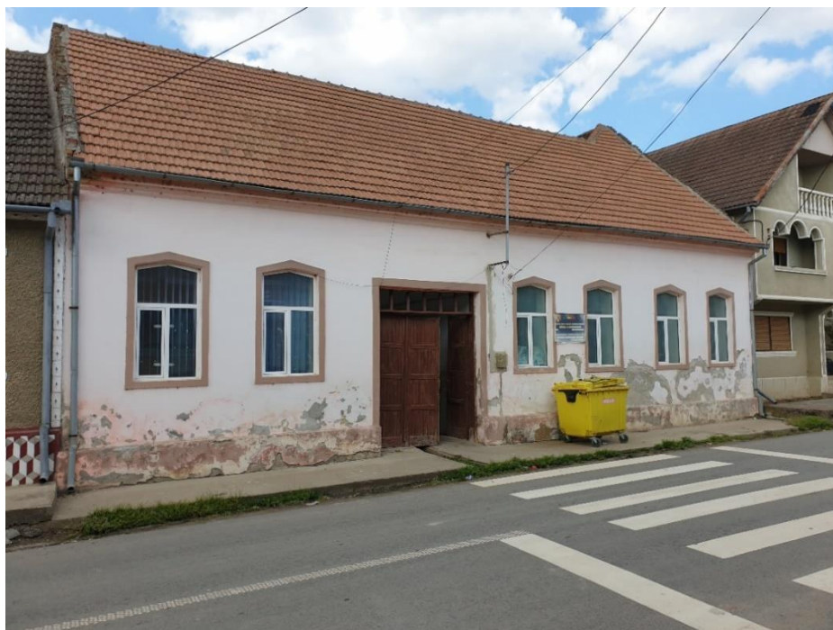
FOTO 1 – Vedere din exterior – amplasare, vecinătăți
