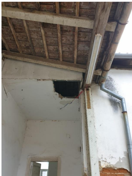
FOTO 39, FOTO 40 –Imagine din pridvor și din holul de acces la grupurile sanitare. Tavan din placaj rupt și cu porțiuni care atârnă. Umiditate marcată la baza pereților și pardoselii, cu micro vegetație prezentă. Zona în ansamblu este insalubră
