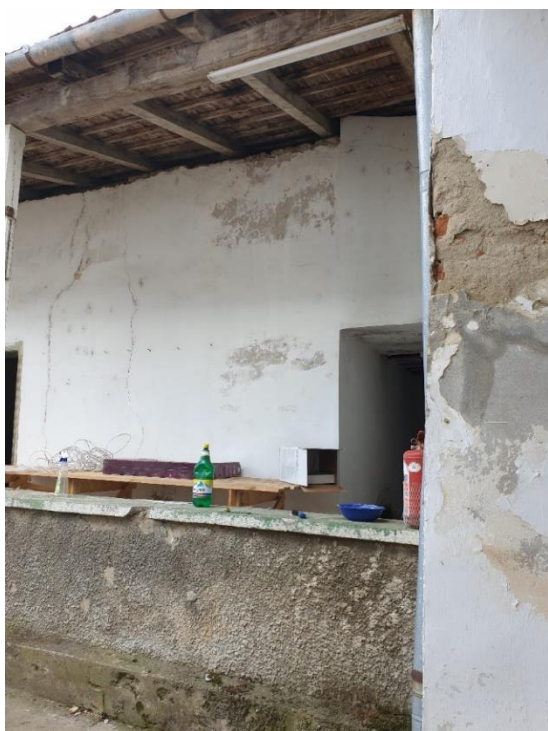
FOTO 12, FOTO 13 –Șpalet zidărie cu tencuiala măcinată, parțial desprinsă. Pridvor cu stâlpii din lemn deformați, parapet afectat de umiditate, cu tencuiala desprinsă
