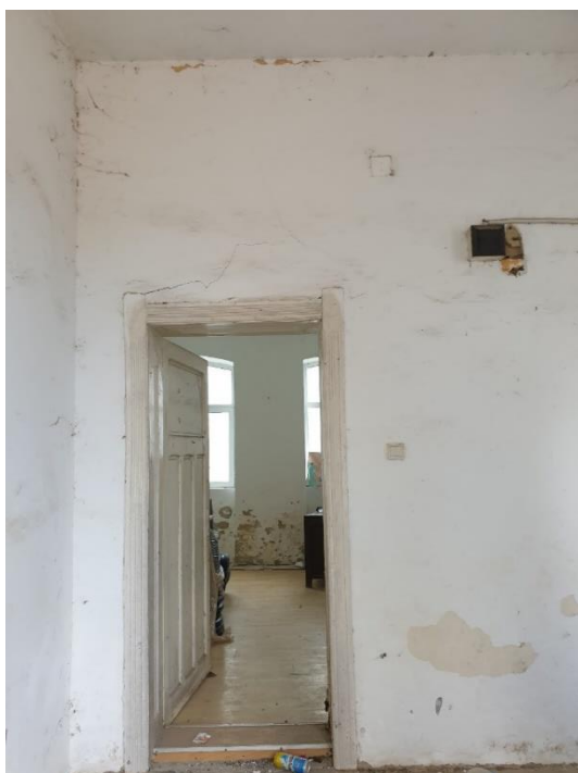
FOTO 45, FOTO 46 –Imagini din interior, încăperile dinspre stradă (camerele 3, 4). Zugrăvelile sunt vechi și cu zone exfoliate. Tâmplăriile sunt vechi și degradate
