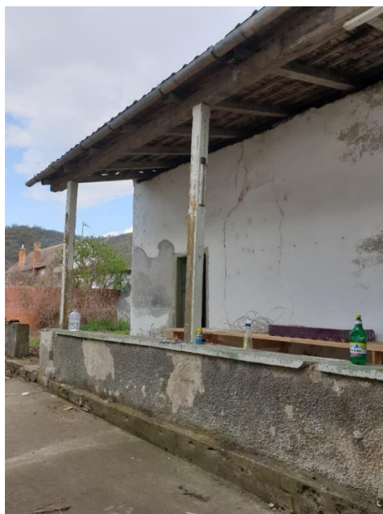
FOTO 12, FOTO 13 –Șpalet zidărie cu tencuiala măcinată, parțial desprinsă. Pridvor cu stâlpii din lemn deformați, parapet afectat de umiditate, cu tencuiala desprinsă
