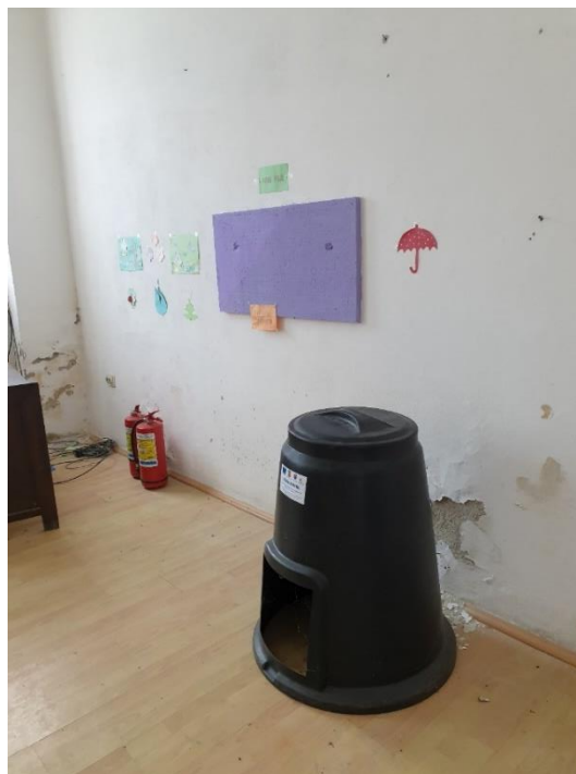
FOTO 47, FOTO 48 –Imagini din interior, încăperile dinspre stradă (camerele 3, 4). Zugrăvelile sunt vechi și cu zone exfoliate. La baza pereților, tencuiala este măcinată, cu desprinderi locale, indicând prezența umidității la partea inferioară a pereților, Tâmplăriile sunt vechi și degradate.
