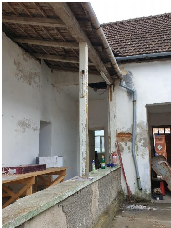
FOTO 28, FOTO 29 – Pridvor cu stâlpii deformați, elementele din lemn ale acoperișului afectate de umiditate și deformat, jgheaburi vechi și deformat. Fisuri/crăpături prezente la perete longitudinal ax D, între 4 și 5. Vegetație crescută pe pardoseala din beton a pridvorului. Tencuieli reparate impropriu. Tâmplării vechi, degradate
