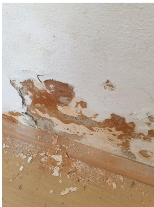
FOTO 58, FOTO 59 –Imagini din interior, încăperile dinspre stradă (camerele 3, 4). Zugrăvelile sunt vechi și cu zone exfoliate. La baza pereților, tencuiala prezintă desprinderi locale, indicând prezența umidității la partea inferioară a pereților
