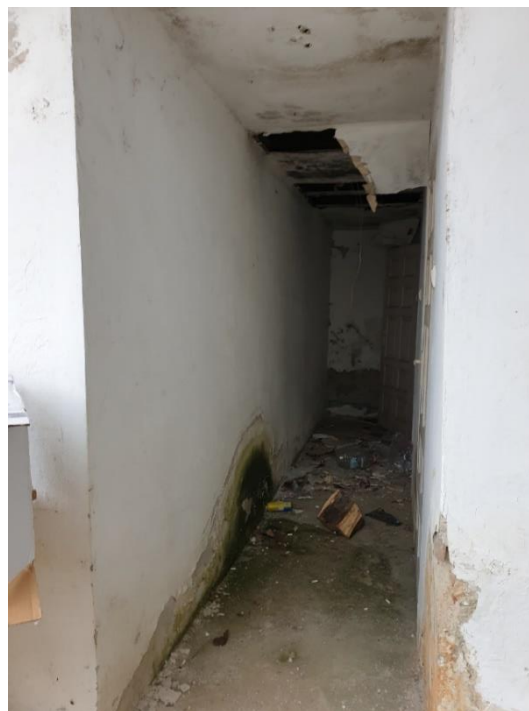
FOTO 39, FOTO 40 –Imagine din pridvor și din holul de acces la grupurile sanitare. Tavan din placaj rupt și cu porțiuni care atârnă. Umiditate marcată la baza pereților și pardoselii, cu micro vegetație prezentă. Zona în ansamblu este insalubră
