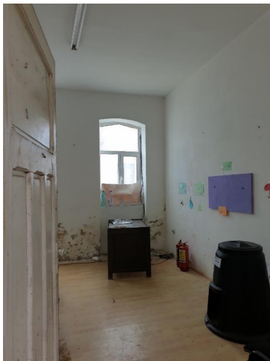
FOTO 47, FOTO 48 –Imagini din interior, încăperile dinspre stradă (camerele 3, 4). Zugrăvelile sunt vechi și cu zone exfoliate. La baza pereților, tencuiala este măcinată, cu desprinderi locale, indicând prezența umidității la partea inferioară a pereților, Tâmplăriile sunt vechi și degradate.
