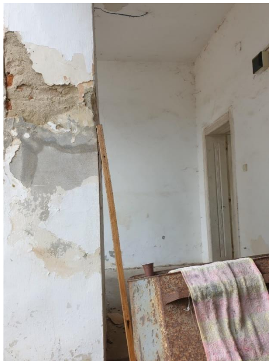
FOTO 10, FOTO 11 –Șpalet zidărie pe care reazemă grinda din vecinătatea șirului 3, dintre B și C (pe latura dinspre curte a intrării uscate). Local, tencuiala șpaletului este măcinată, parțial desprinsă
