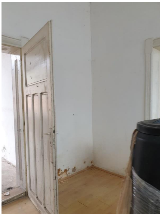
FOTO 51, FOTO 52 –Imagini din interior, încăperile dinspre stradă (camerele 3, 4). Zugrăvelile sunt vechi și cu zone exfoliate. La baza pereților, tencuiala este măcinată, cu desprinderi locale, indicând prezența umidității la partea inferioară a pereților, Tâmplăriile sunt vechi și degradate.
