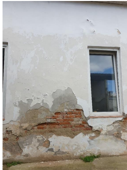
FOTO FOTO 16, FOTO 17 – Perete portant longitudinal ax B, zona dintre șirurile 2 și 4. Local, tencuiala este măcinată, parțial desprinsă la partea inferioară a peretelui. În zonele în care tencuiala s-a desprins, liantul zidăriei este afectat la suprafață peretelui. Burlan vechi, neetanș. Îndepărtarea apei pluviale nu se realizează corespunzător, ci este deversată pe platforma din beton existentă în curte
