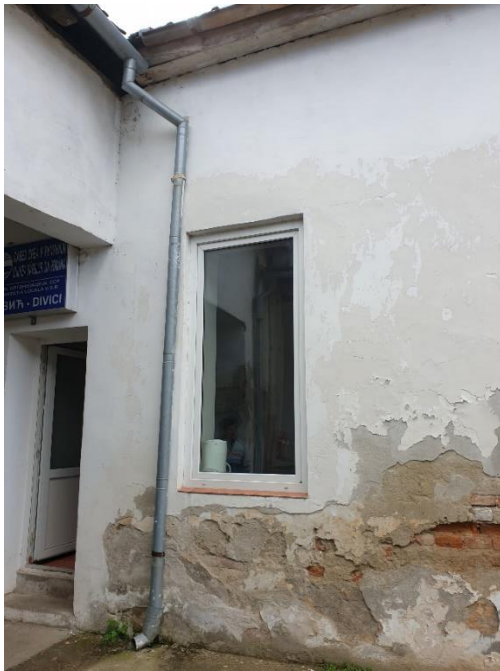
FOTO FOTO 16, FOTO 17 – Perete portant longitudinal ax B, zona dintre șirurile 2 și 4. Local, tencuiala este măcinată, parțial desprinsă la partea inferioară a peretelui. În zonele în care tencuiala s-a desprins, liantul zidăriei este afectat la suprafață peretelui. Burlan vechi, neetanș. Îndepărtarea apei pluviale nu se realizează corespunzător, ci este deversată pe platforma din beton existentă în curte
