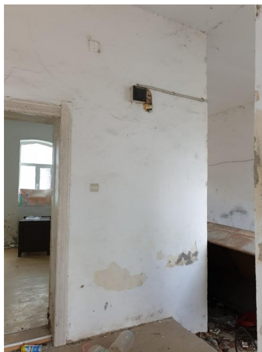
FOTO 45, FOTO 46 –Imagini din interior, încăperile dinspre stradă (camerele 3, 4). Zugrăvelile sunt vechi și cu zone exfoliate. Tâmplăriile sunt vechi și degradate
