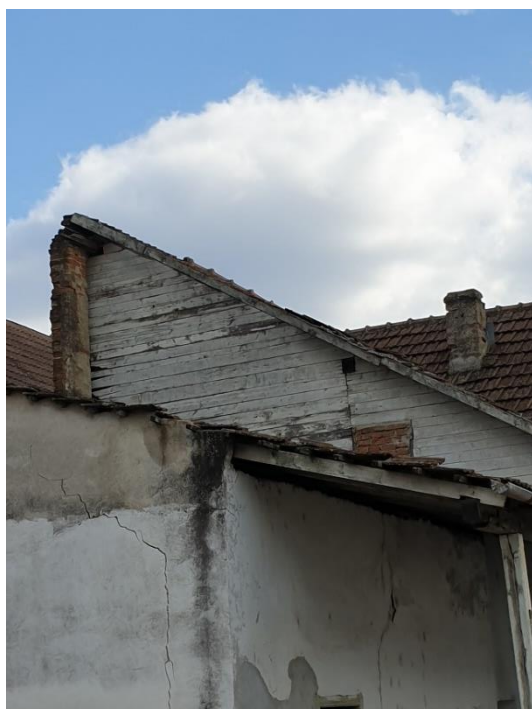
FOTO 23, FOTO 24 — Fisuri prezente la pereții portanți de pe șir 5, dintre D și F și din ax D, dintre 3 și 5. Pridvor cu stâlpii din lemn deformați, parapet afectat de umiditate, cu tencuiala desprinsă. Calcan existent pe șir 3, între D și F, închis cu scânduri, puternic afectate de umiditate. Țigla este învechită la toate apele dinspre curte, a fost înlocuită doar spre stradă.
