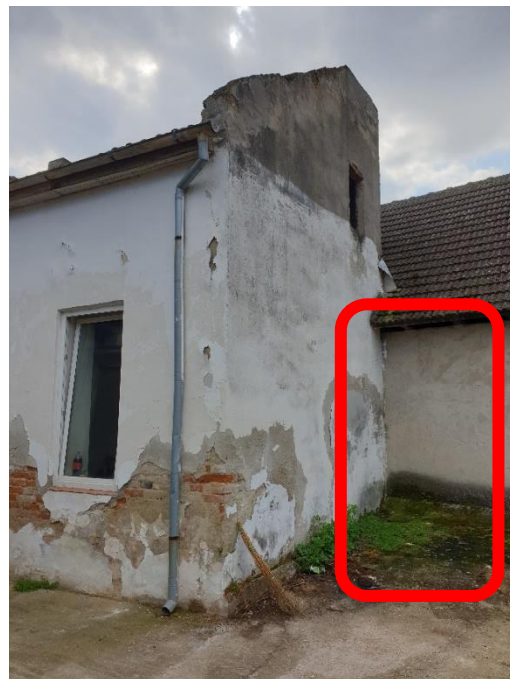
FOTO 18, FOTO 19 – Perete portant longitudinal ax B și perete transversal șir 4 – zona de intersecție B4. Tencuiala este măcinată, parțial desprinsă la partea inferioară a peretelui, umiditate prezentă la partea inferioară a pereților. Calcan existent spre curte, la zidul transversal. Alipire la construcția de pe parcela învecinată din partea stângă
